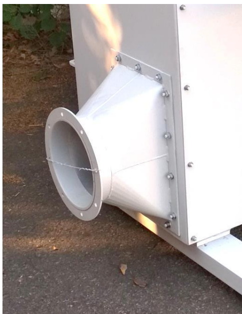
Namontovaný přechod bez izolace
